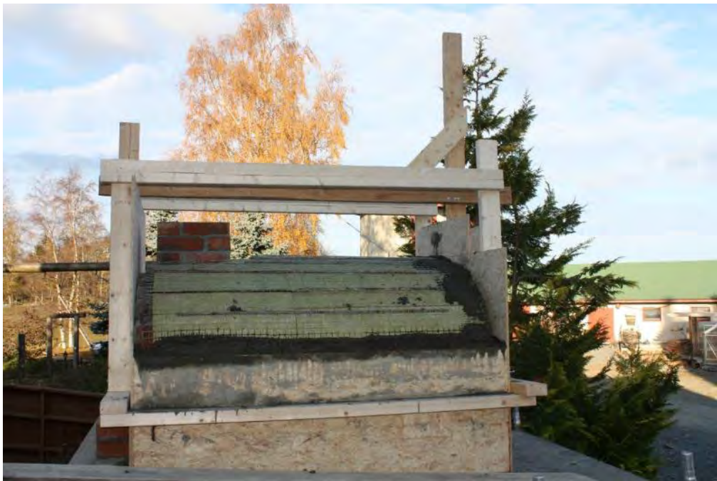
Her ser du pipa er murt ferdig.
