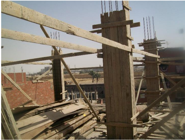
Frå byggearbeidet for toppetasjen med aldersbustader, Foto: GFS
